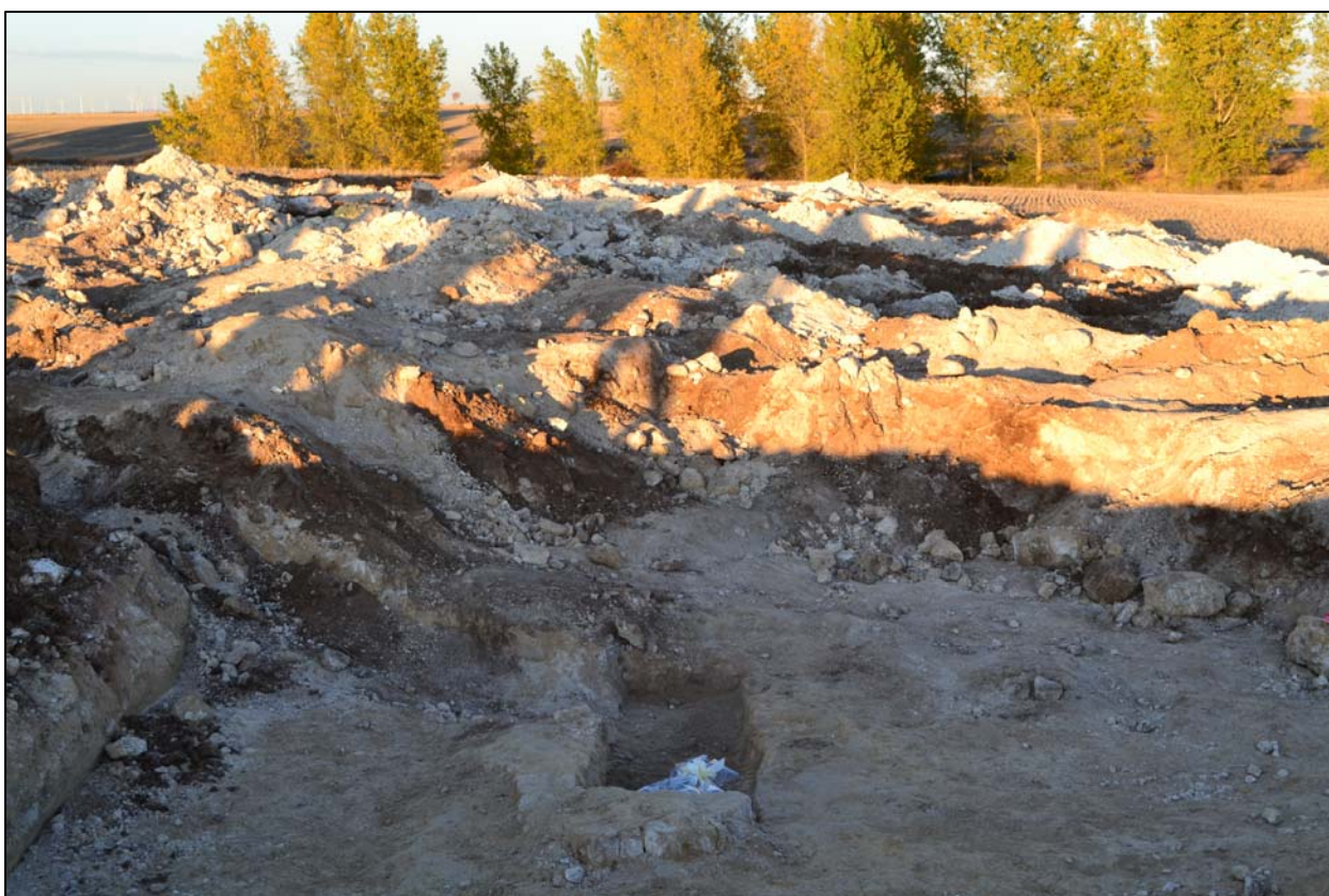
Fig. 33. Panorámica de las zanjas abiertas en el paraje de Tablín para localizar la fosa común.
