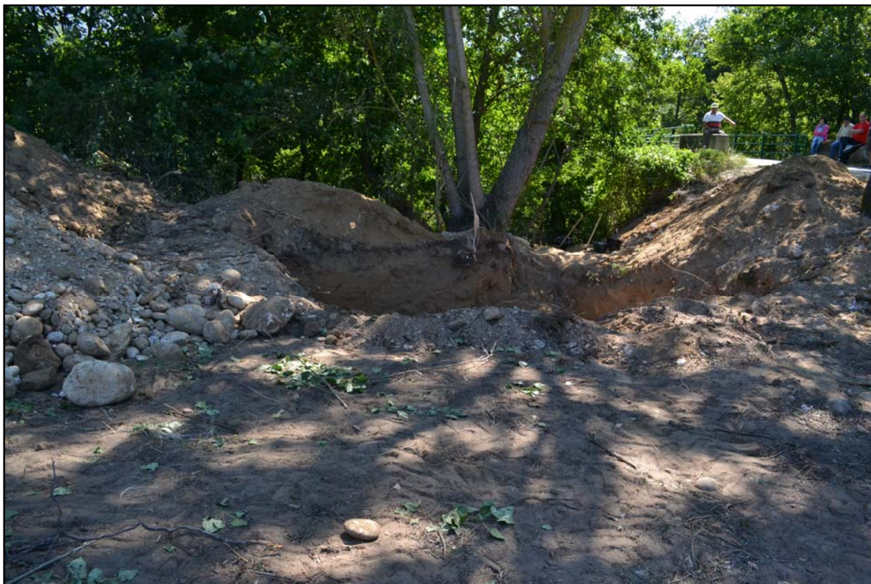
Fig. 15. Vista del emplazamiento de la fosa una vez retirada la cobertura vegetal del entorno con medios mecánicos.
